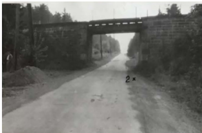
Abb. 3: Eisenbahnbrücke in Česká Hamry, hier wurde Jaroslav Soukup von Sudars angeschossen.
