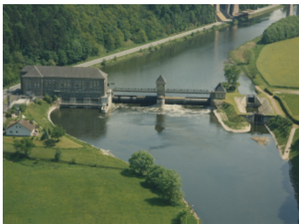
Abb. 1: Staustufe 'Letzter Heller', Werra Quelle: Bundesanstalt für Wasserbau, (CC BY 4.0)
